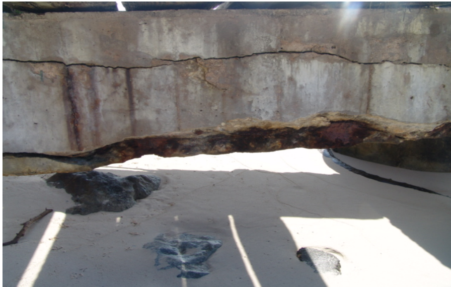
Figura 3-15 Vigas en concreto para soportar la plataforma
