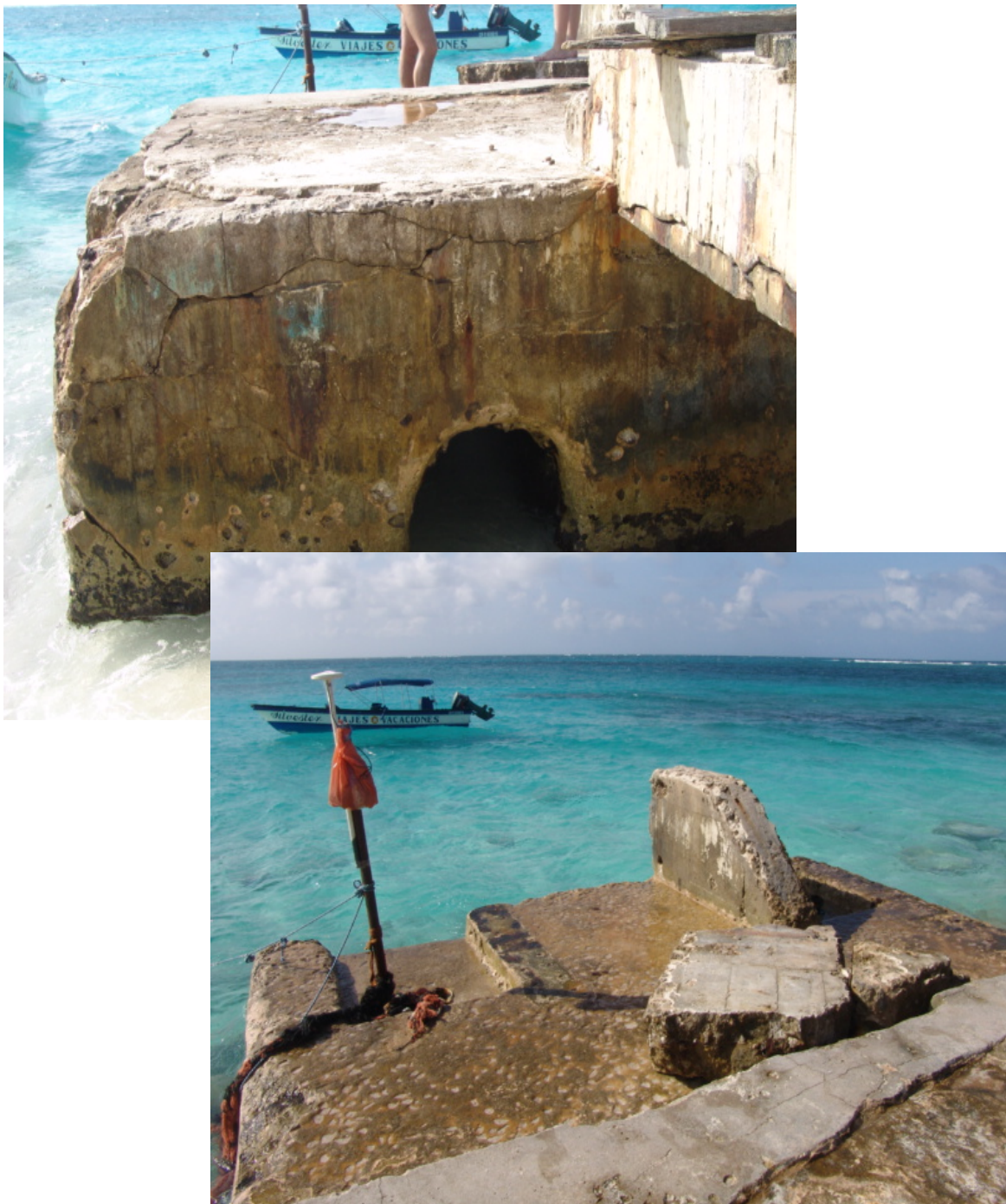
Figura 3-12. Cimientos y base en concreto del muelle flotante
