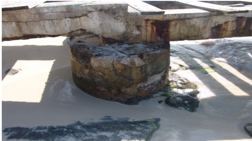
Figura 3-14. Base en concreto del muelle, entrada a la plataforma
