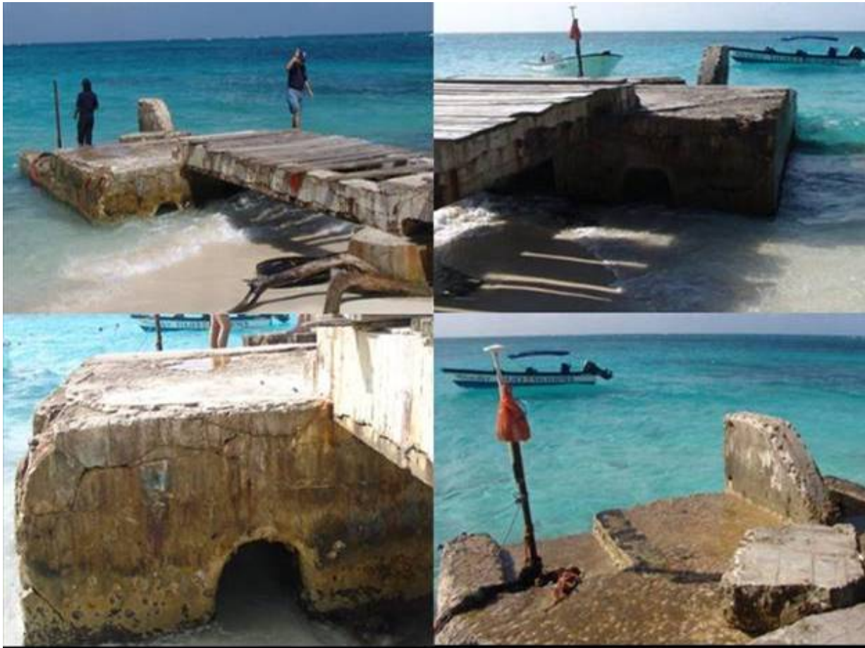
Figura 4.6 Muelle flotante en servicio restringido actualmente. con sus cimientos y base en concreto
