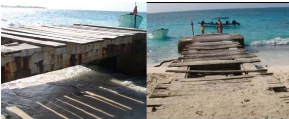
Figura 4.8 Plataforma del muelle flotante en uso restringido actualmente..
