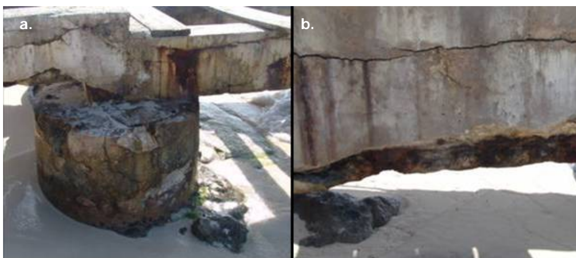
Figura 4.7 Muelle flotante: a. Base en concreto en la entrada a la plataforma. b. Vigas en concreto para soportar la plataforma
