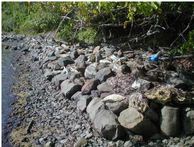
Figura 8 Relleno y construcción de muro sobre la línea de costa.
